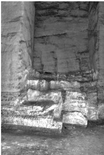
Obr. 4. Tarquinie, prov. Viterbo, reg. Lazio. Lom poblíž nekropole Monterozzi. Způsob tzv. lavicové těžby. Kromě horizontálních lavic se těžilo v definovaných vertikálních sloupcích.
